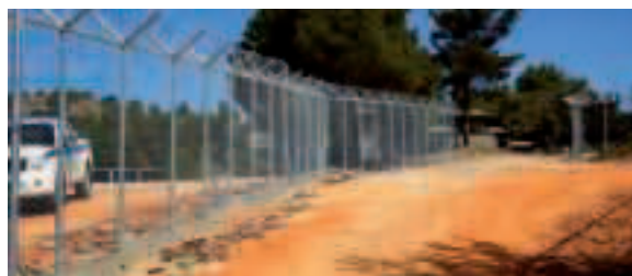
Im Dorf Pyli entsteht ein Durchgangslager für allfällige Flüchtlinge.
